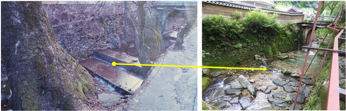
[그림 VIII-10] 계룡산국립공원 숙모전 보 철거 전·후 전경
